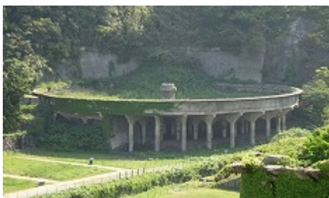
直径 50mのシックナー、混濁液から金銀を選鉱するそうだ。
